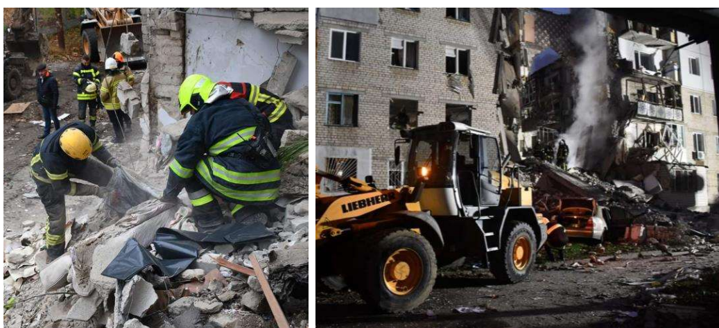
Рис. 3. Проведення пошукових та АРР на зруйнованих будівлях
