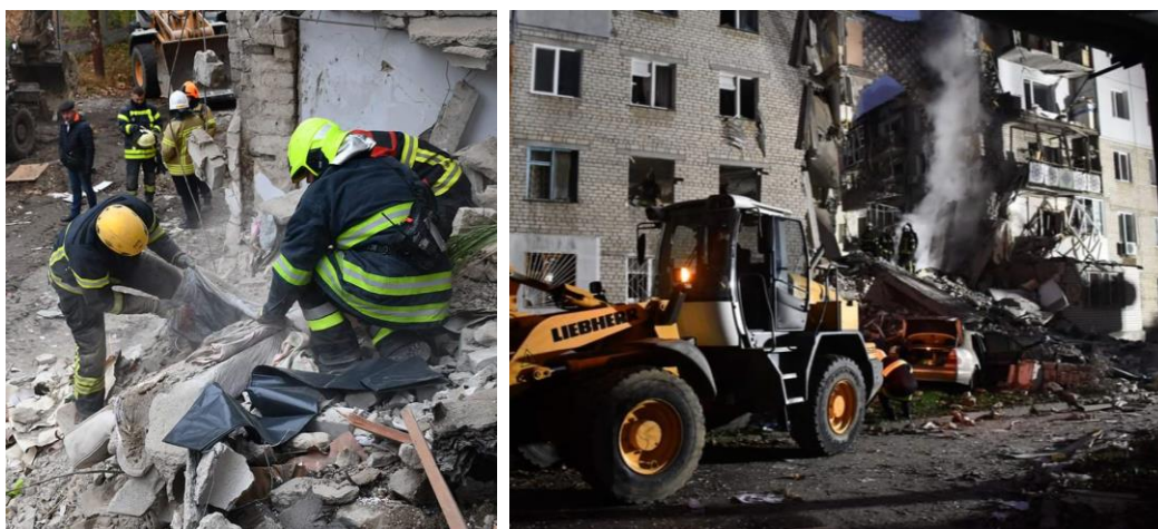
Рис. 3. Проведення пошукових та АРР на зруйнованих будівлях
