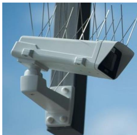
Рис. 7.2. Камери зовнішнього відеоспостереження
