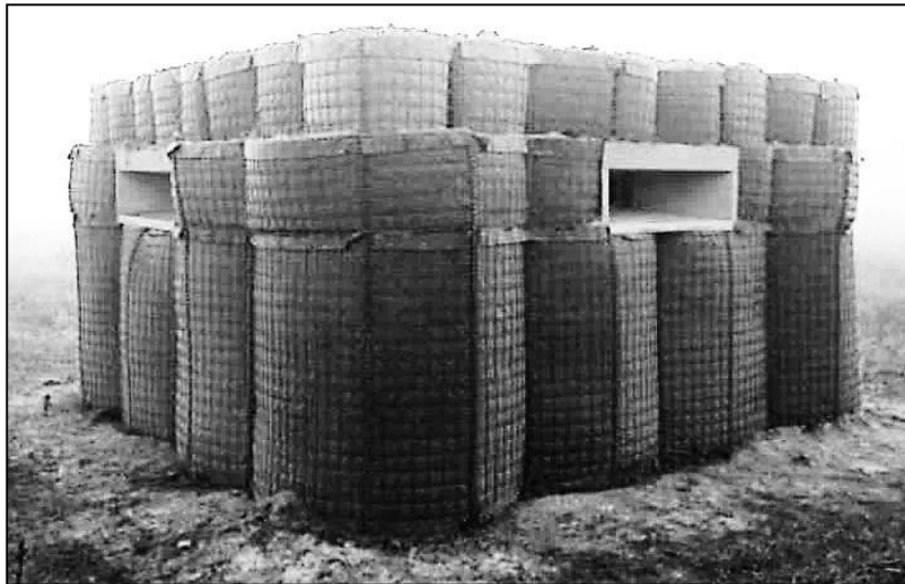
Рис. 62. Мобільна габіонна конструкція Гарда-6
