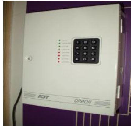
Рис. 6.3. Зовнішній вигляд ППК «Оріон 4Т»: а– внутрішня будова; б –зовнішній вигляд
